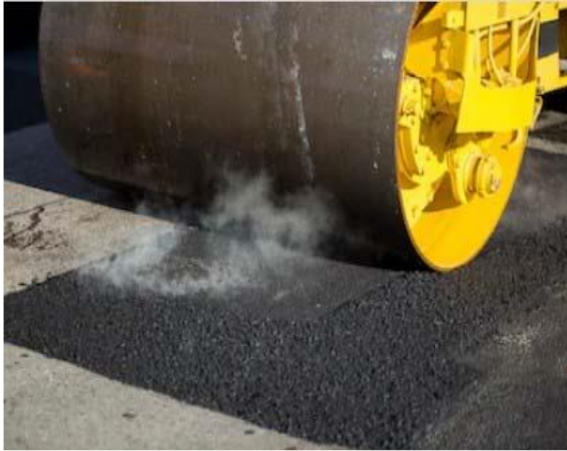
Figura 4 - Revestimento de CBUQ
