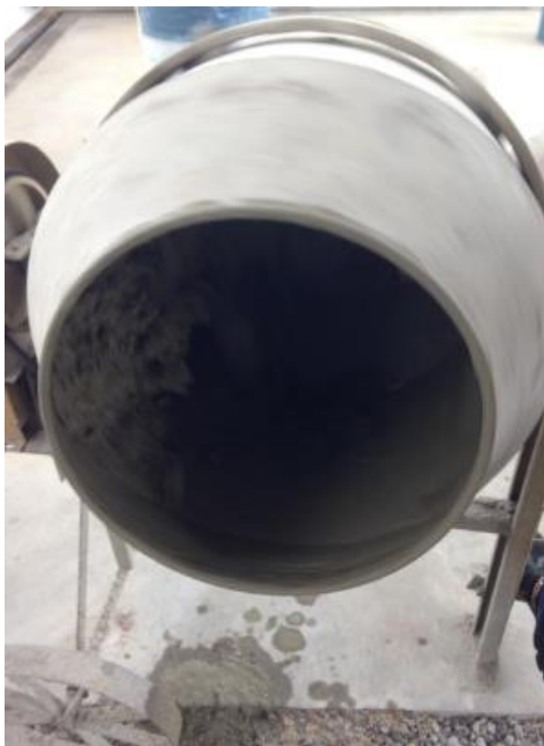
Figura 6 – Mistura dos materiais na betoneira
