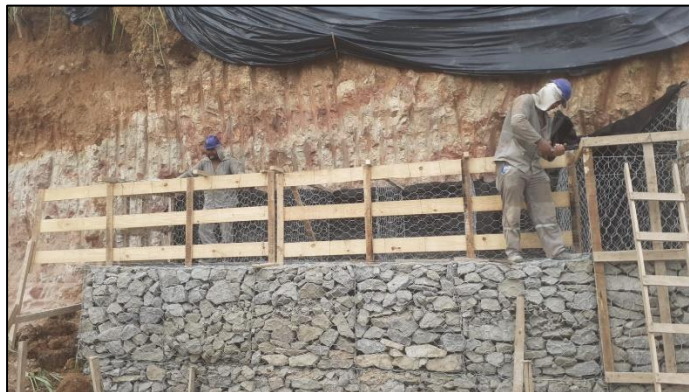
(Figura 13: Preenchimento das telas do muro de gabião) Fonte: Autoral
