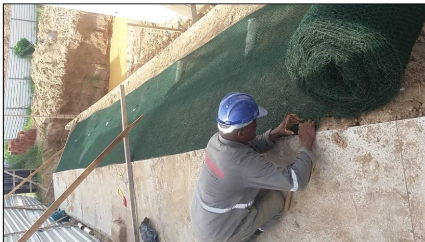
(Figura 14: Aplicação da geomanta) Fonte: Autoral
