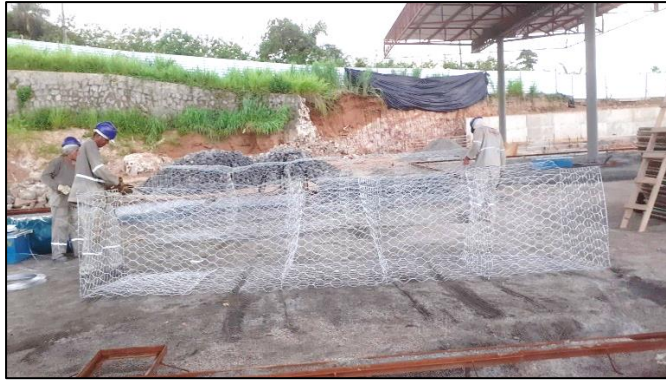
(Figura 12: Montagem das caixas/telas do muro de gabião) Fonte: Autoral
