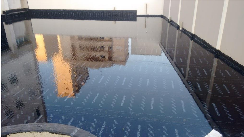
(Figura 5 : Teste de estanqueidade com lâmina de água)
