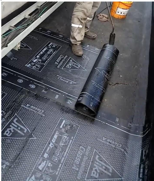
(Figura 1 - Manta a base de asfalto modificado com polímeros e estruturada com filme de polietileno)
