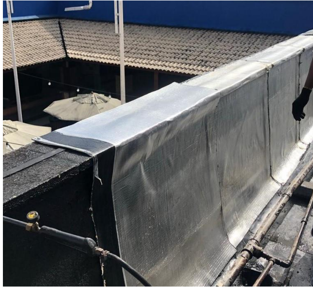
(Figura 2: Manta Alumínio estruturada com filme de polietileno de alta densidade ou poliéster pré-estabilizado)
