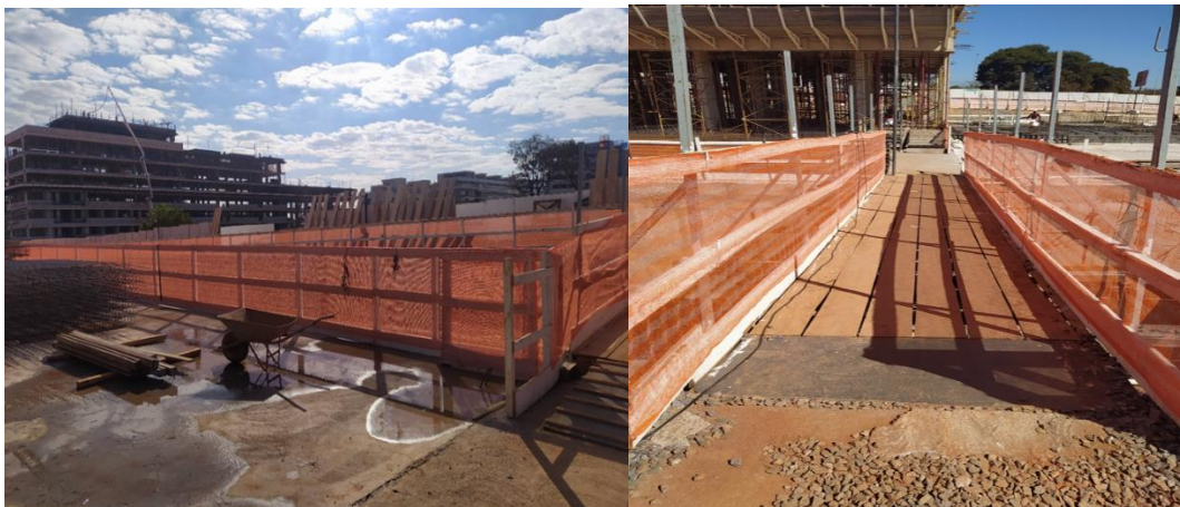
Figura 2: Instalação de um guarda corpo.
