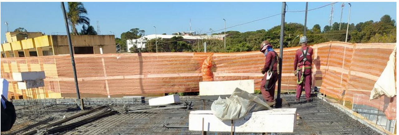
Figura 9: Guarda-corpo e linha de vida horizontal
