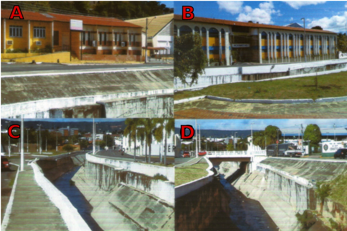
Figura 11 – Canal reconstruído depois da enchente de 2011. A - CEJA, B - Colégio Objetivo, C- Canal com maior profundidade, D - Ponte que dá acesso ao Tiro de Guerra, Colégio Objetivo e CEJA
