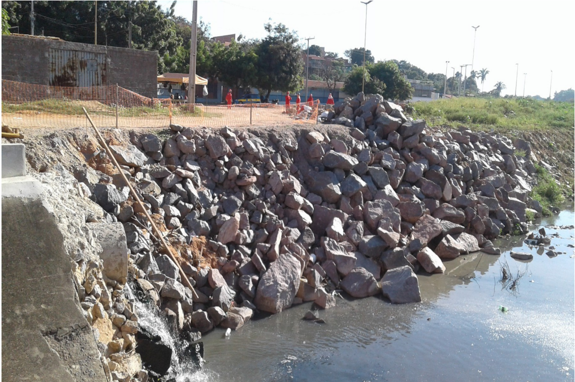
Figura 17 – Obras contínuas do canal, depois do Mercado José Walter Peixoto
