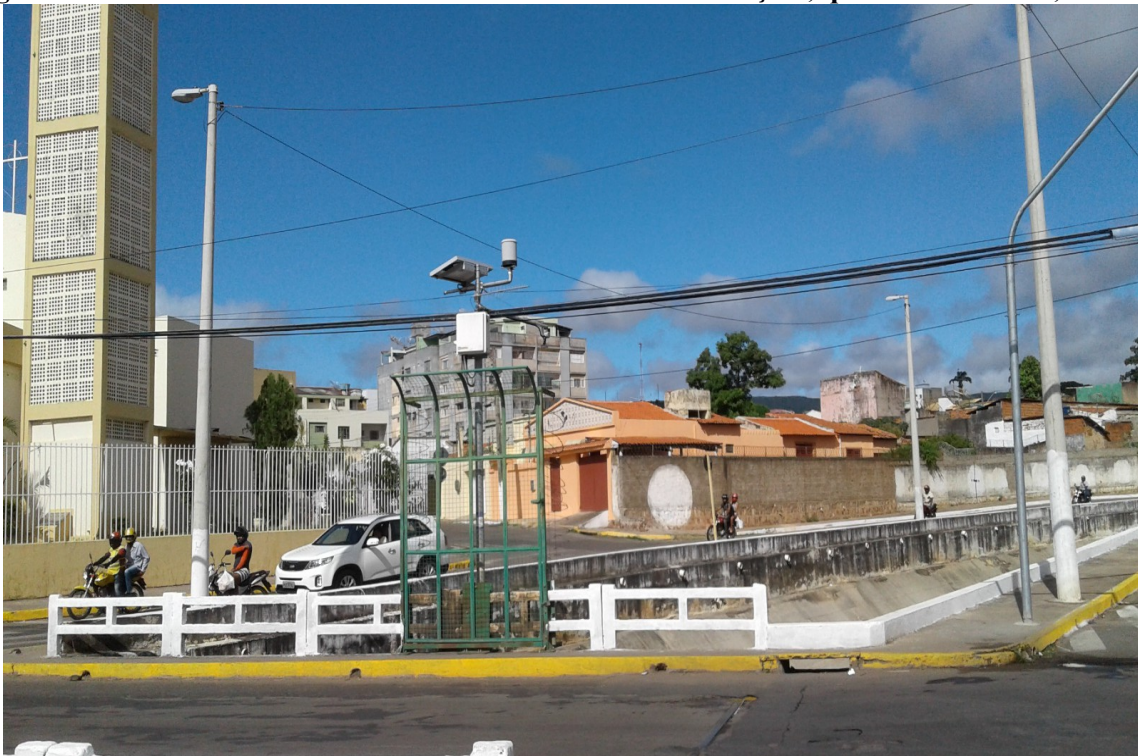
Figura 10 – Ponte reformada com Sistema de Alerta de Inundações, que não funcionou, em 2019
