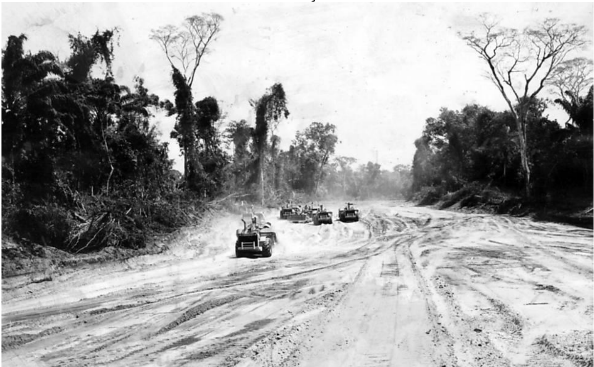
Figura 01: Tratores fazem terraplanagem em trecho da Rodovia Transamazônica ainda em construção
