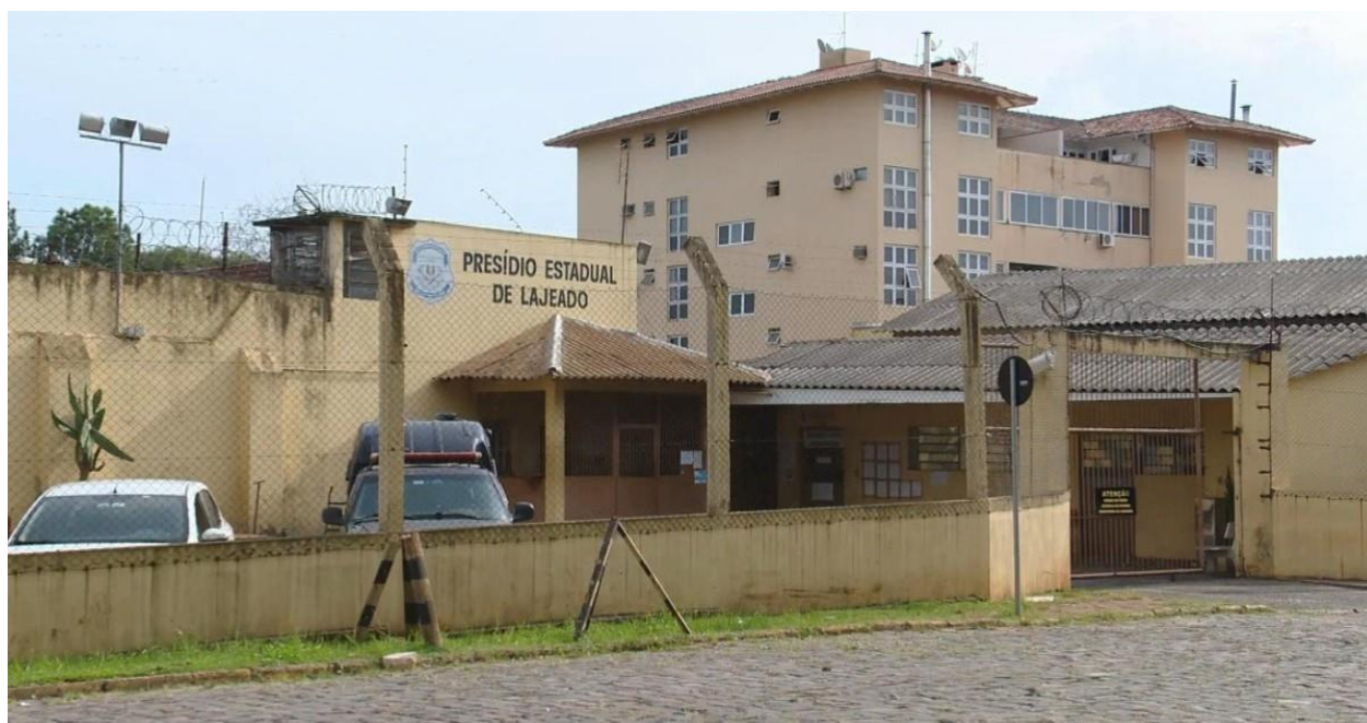
Fotografia 01 – Presídio Estadual de Lajeado RS
